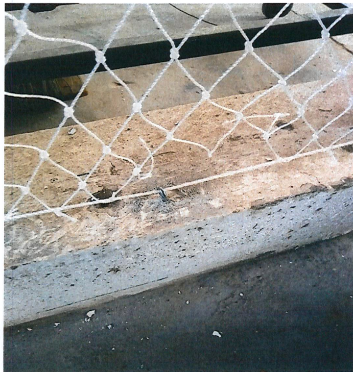
Foto n.º 03 – Visualização do ensaio após o impacto de corpo mole – Ruptura da rede na região inferior em 02 malhas.
